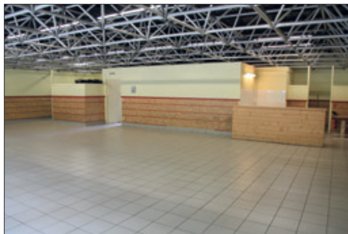
L'intérieur du club Égletons montre la structure tubulaire, particularité de ce bâtiment.
