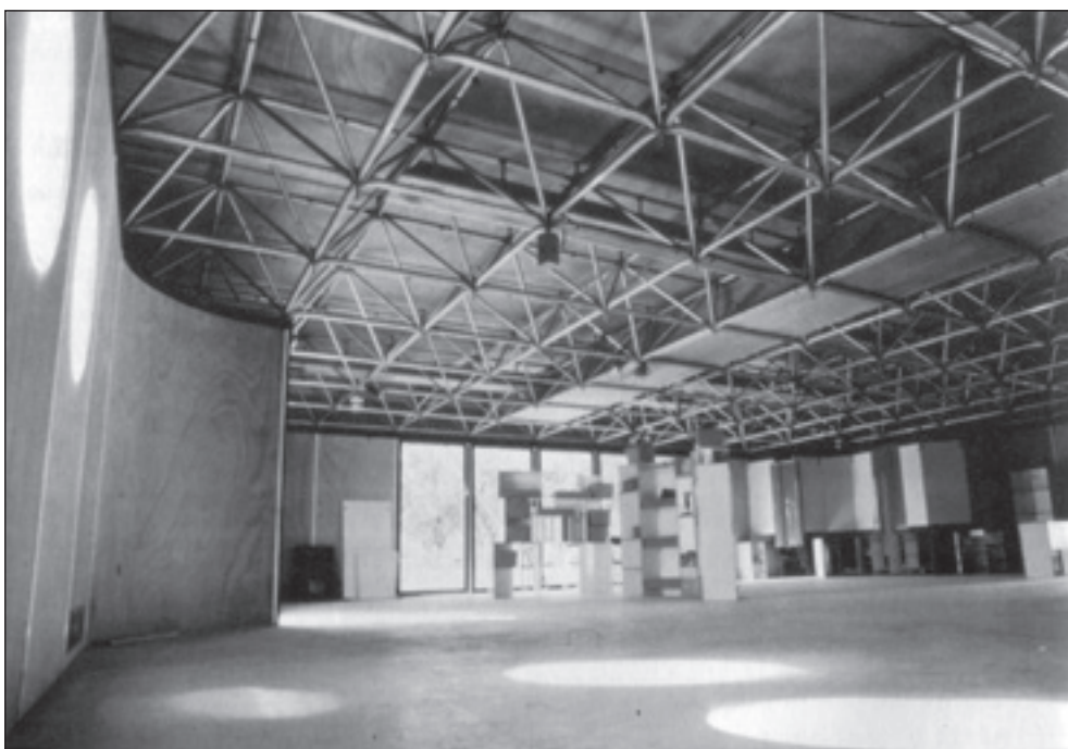
Vue intérieure d'un Club des jeunes Tridim 120. La structure en treillis qui supporte la toiture est bien visible. Elle permet le passage de la gaine de chauffage.
