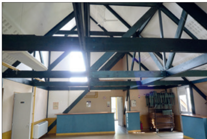
Le club de Sainte-Bazille (Lot-et-Garonne) montre la structure des poutres en bois pour les niveaux supérieurs.
