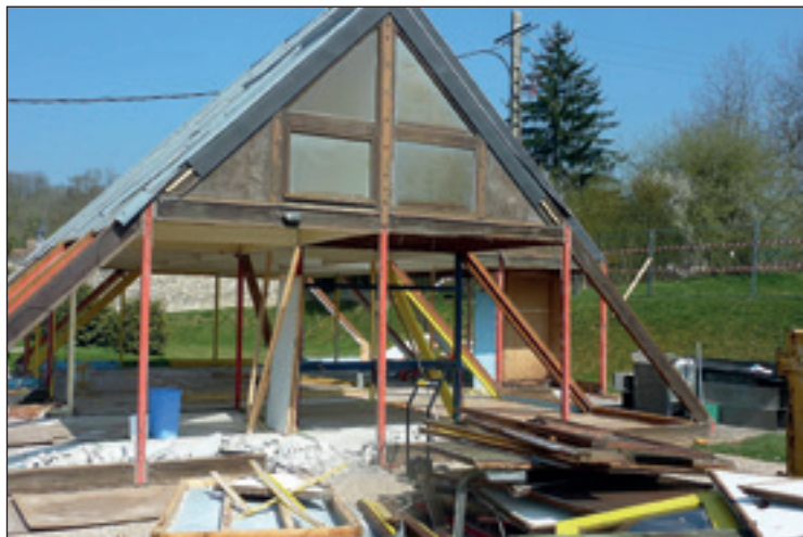
Les travaux de rénovation (2012) du Mille club de Montreuil-sur-Epte (Val-d'Oise) montrent la structure au rez-de-chaussée. Les poteaux porteurs sont peints en rouge et, malgré l'absence des murs, ils supportent les deux niveaux supérieurs.
