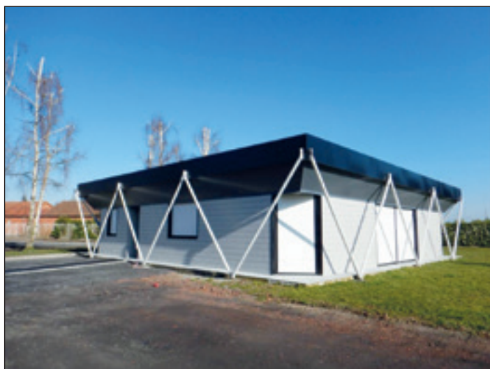
Flines-lez-Raches (Nord). Ici, le treillis métallique supportant la toiture a été masqué par un plafond. Les travaux datent de 2014. © Mairie de Flines-lez-Raches.
