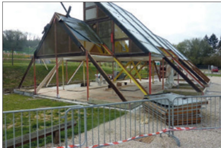
Les travaux de rénovation (2012) du Mille club de Montreuil-sur-Epte (Val-d'Oise) montrent la structure au rez-de-chaussée. Les poteaux porteurs sont peints en rouge et, malgré l'absence des murs, ils supportent les deux niveaux supérieurs.
