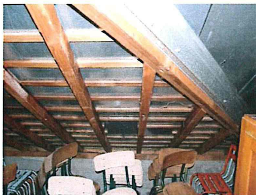
Extension en charpente bois et bac acier
