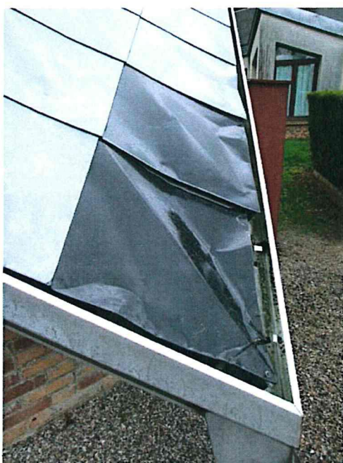
Mauvais état de la couverture et tôles remplacées
