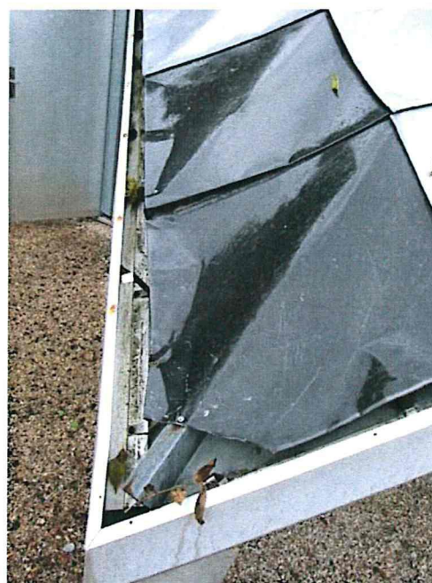
Mauvais état de la couverture et tôles remplacées
