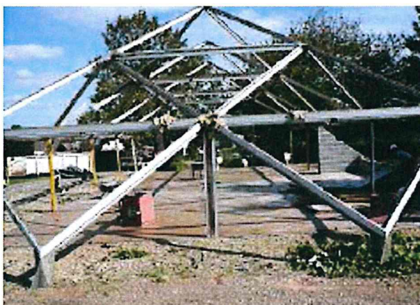
Principe de la structure avant habillage (extrait 1000 clubs)
