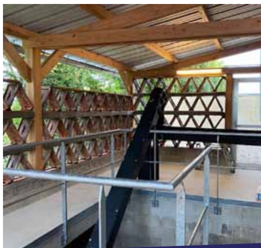
Réemploi des tuiles de l'ancienne grange
